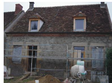
Sur les supports anciens, le corps d'enduit doit recouvrir les matériaux du mur (pierres, briques, etc.) de 10 à 15 mm, à l'exception des chaînages destinés à rester apparents.
