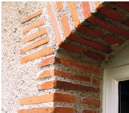
apporte du relief par le jeu des ombres, tandis qu'au nu du parement extérieur, elle accentue l'aspect monolithe du bâtiment. La recherche de l'étanchéité à l'air et du traitement des ponts thermiques guide souvent cette position dans le mur.
