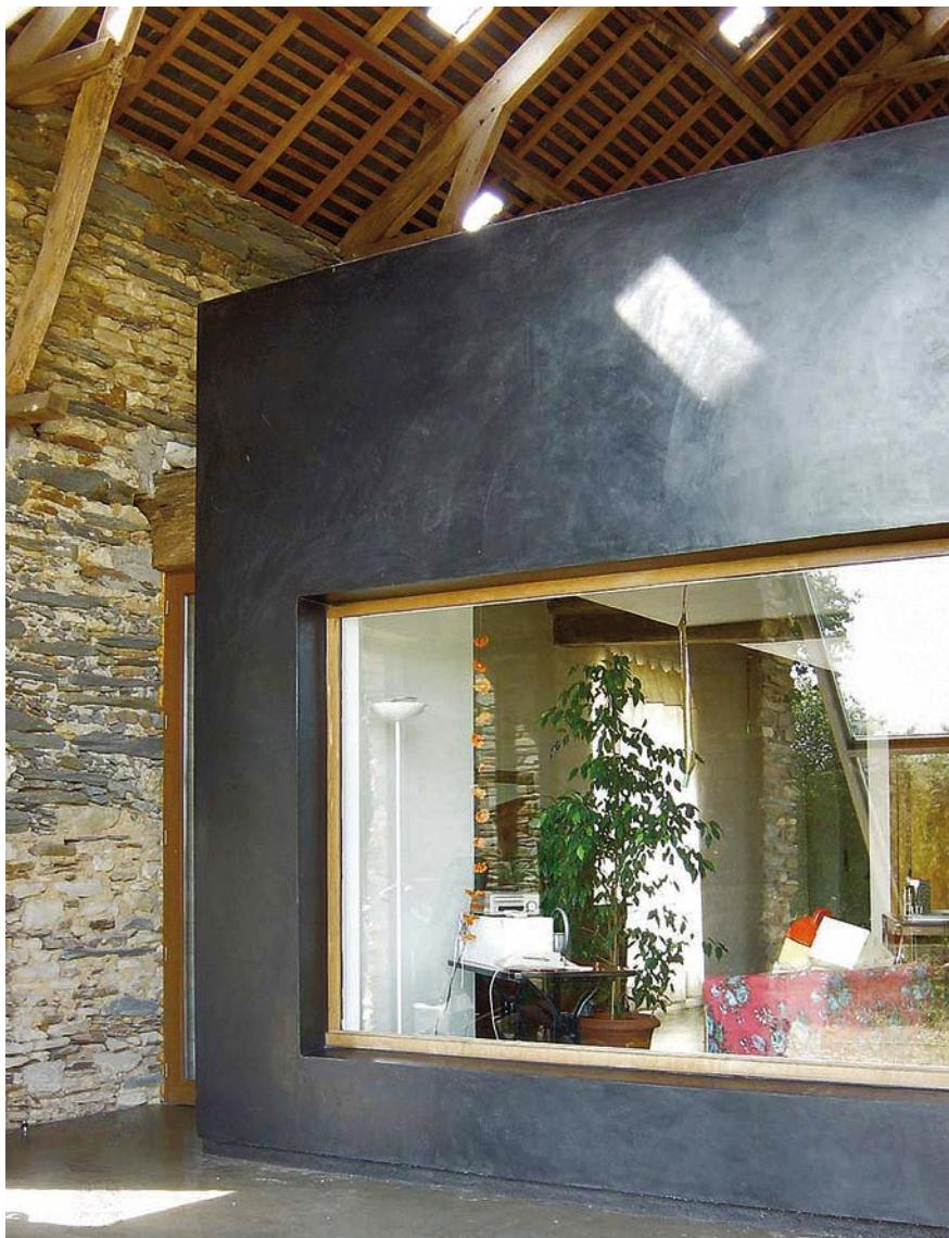
*Ci-dessus, l'habitable isolé est construit, telle une boîte indépendante, « glissée » dans une partie de l'enveloppe du bâtiment initial. Le volume restant forme un « espace tampon » habitable, entre l'intérieur et l'extérieur du bâtiment.*
